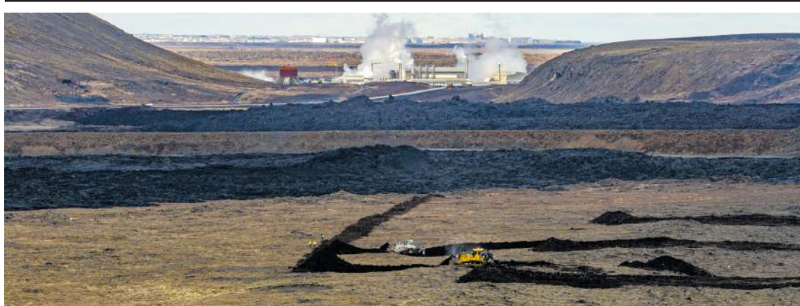
Jarðvitur á vegum verktaka Almannavarna hófu á mánudag að ýta upp nýjum innri varnar- og leiðigardi austan byggðarinnar í Grindavík sem er ætlað að taka á móti hrauni sem mögulega flæðir yfir varnargarða sem eru orðnir barmfullir. VF/Hilmar Bragi
