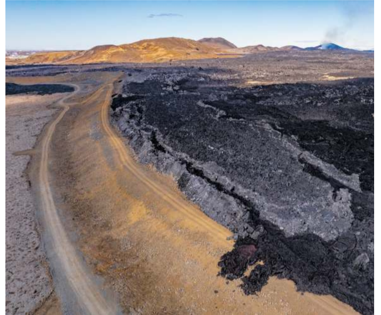
Að ofan: Hraunið er orðið herra en varnargarðurinn austan byggðarinnar í Grindavík.
